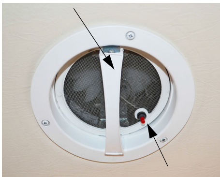
Fan Power Switch
